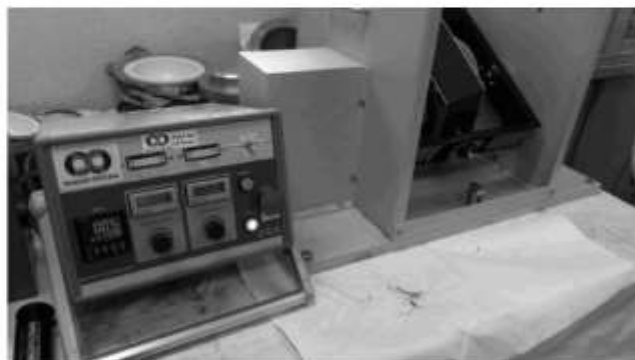
写真2 プログラム制御によって均一作業が可能
